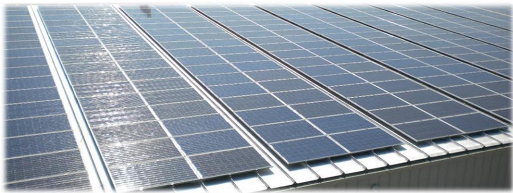
Slika 2-9 FN moduli montirani na način da prate nagib kosog krova
