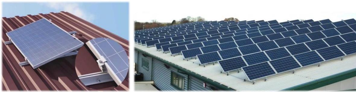
Slika 3-20 Prikaz montažne konstrukcije i ugrađenih FN modula na kosom limenom krovu za Varijantu 2)
