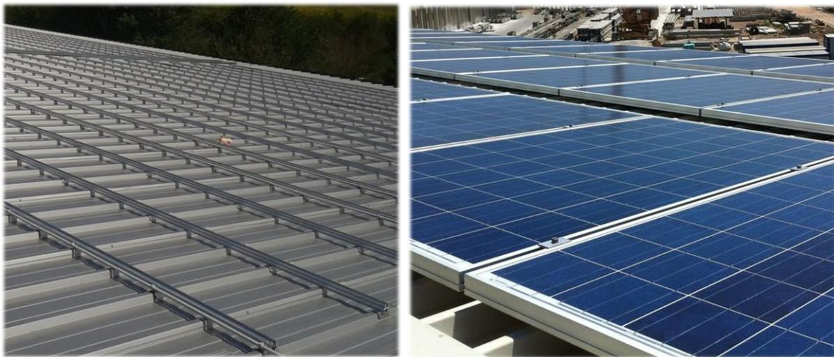
**Slika 3-18 Prikaz montažne konstrukcije i ugrađenih FN modula na kosom limenom krovu za Varijantu 1)**
