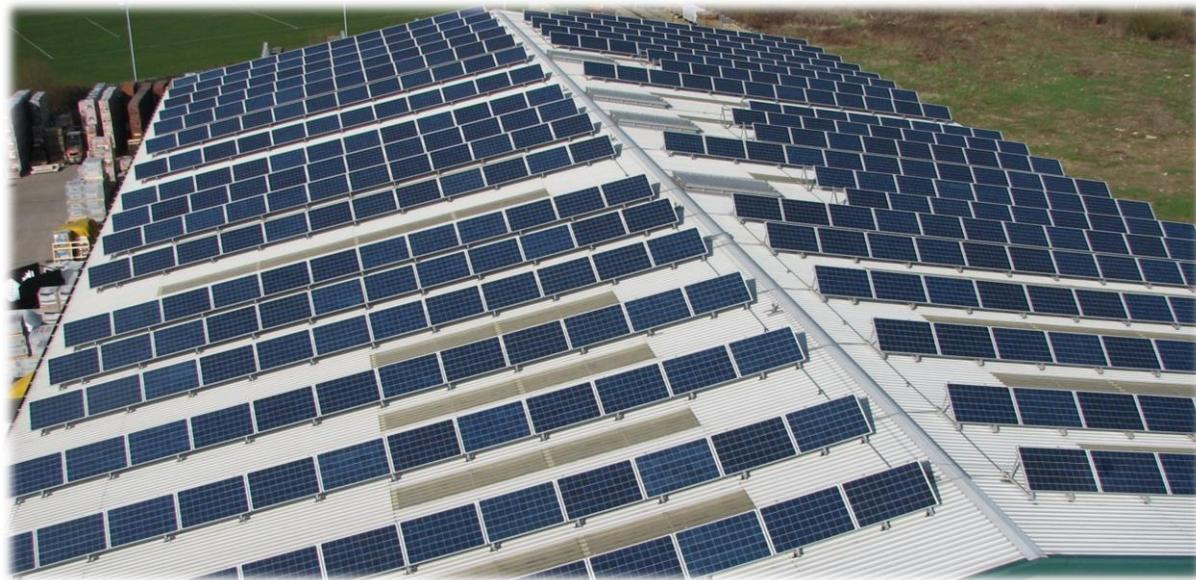
Slika 2-10 FN moduli montirani na način da prate nagib kosog krova
