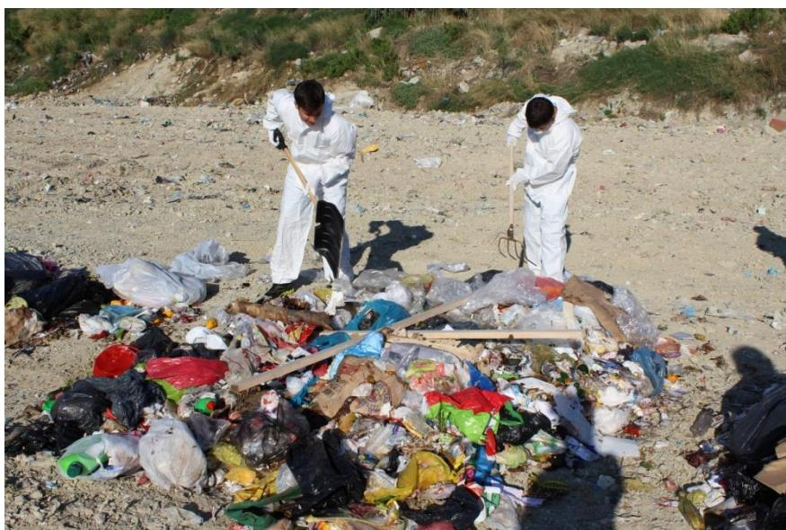
Slika 4.1.1/1 Slika 4.1.1/1 homogenizacija i četvrtanje uzorka, dobiven uzorak od  $0,5 \text{ m}^3$
