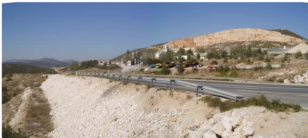
Slika 26. Betonara i kamenolom Križice
