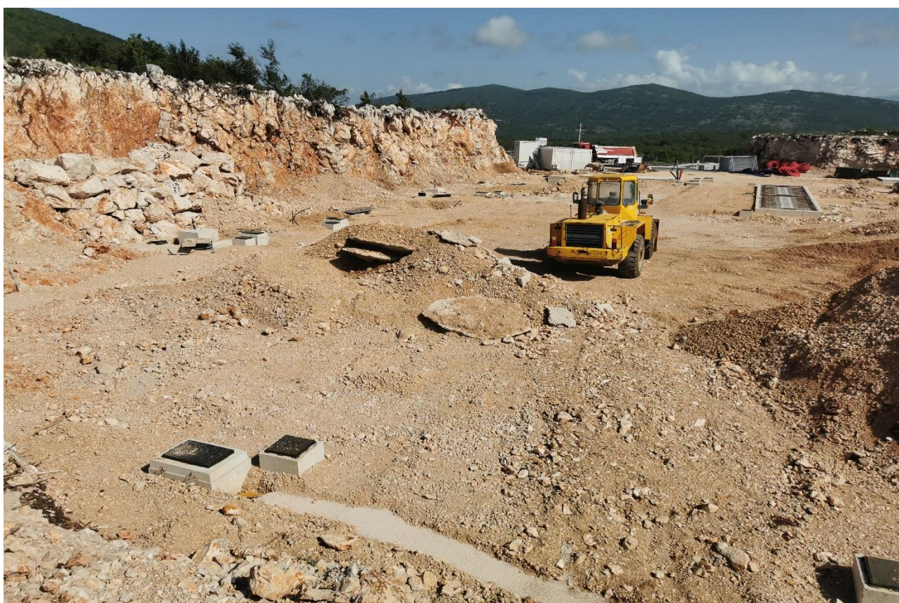
Slika 4: Prikaz radova na izgradnji Pretovarne stanice Zagvozd
