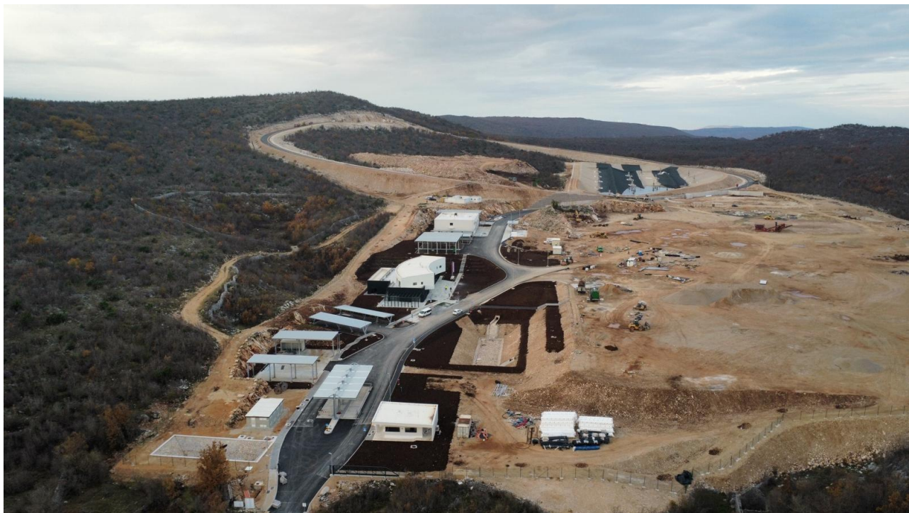
Slika 1: Prikaz radova na lokaciji budućeg Centra za gospodarenje otpadom u Kladnjicama u Općini Lećevica
