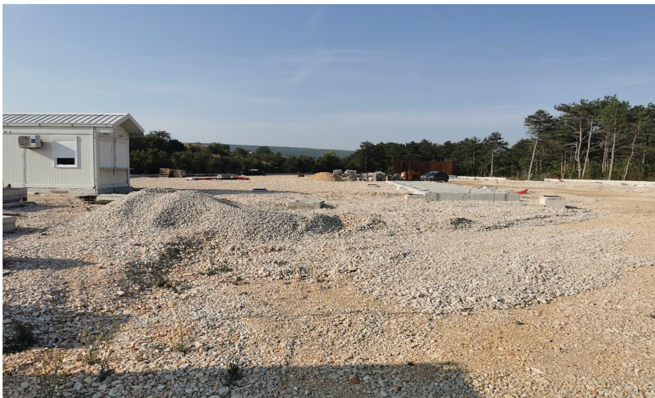
Slika 3: Prikaz radova na izgradnji Pretovarne stanice Sinj
