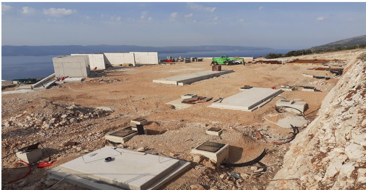
Slika 2: Prikaz radova na izgradnji Pretovarne stanice Brač
