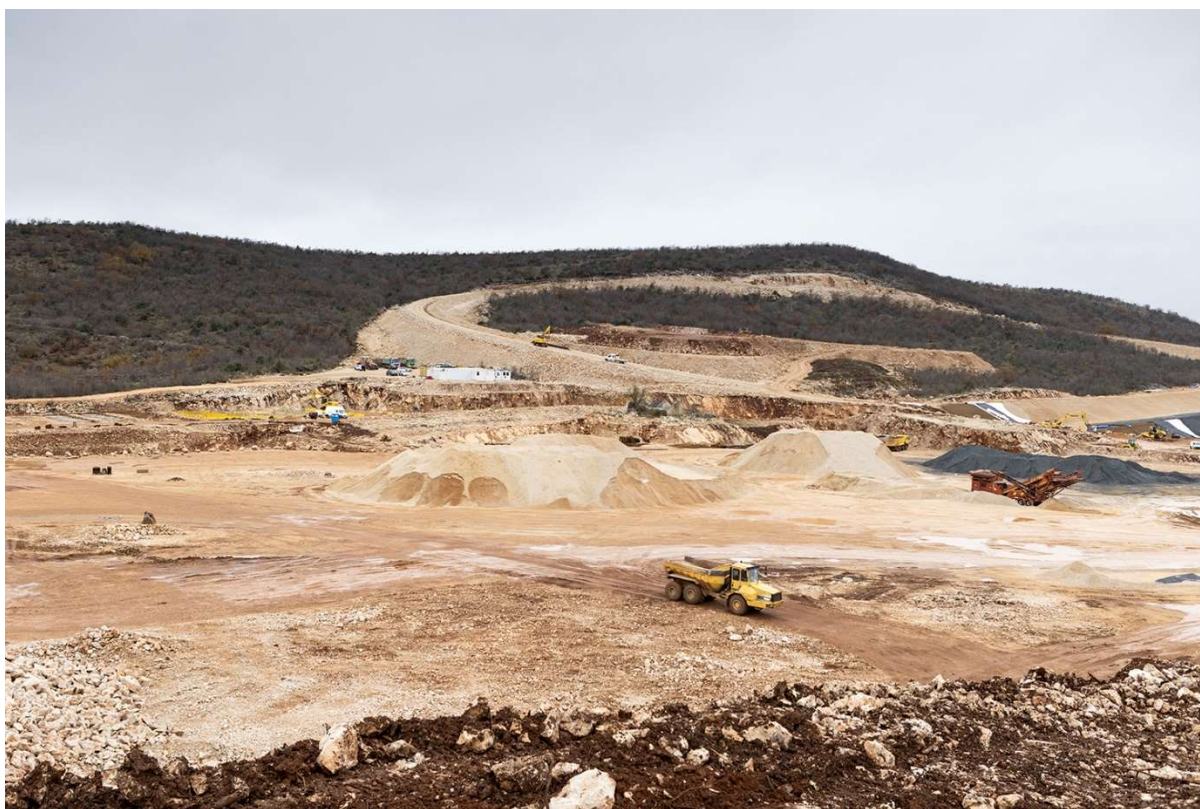
Slika 2: Prikaz radova na lokaciji budućeg Centra za gospodarenje otpadom u Kladnjicama u Općini Lećevica (prosinac 2023.)
