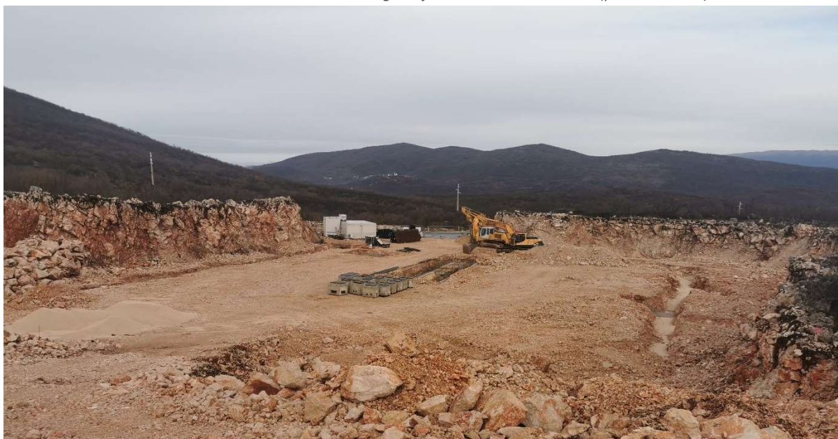
Slika 5: Prikaz radova na izgradnji Pretovarne stanice Zagvozd (prosinac 2023.)
