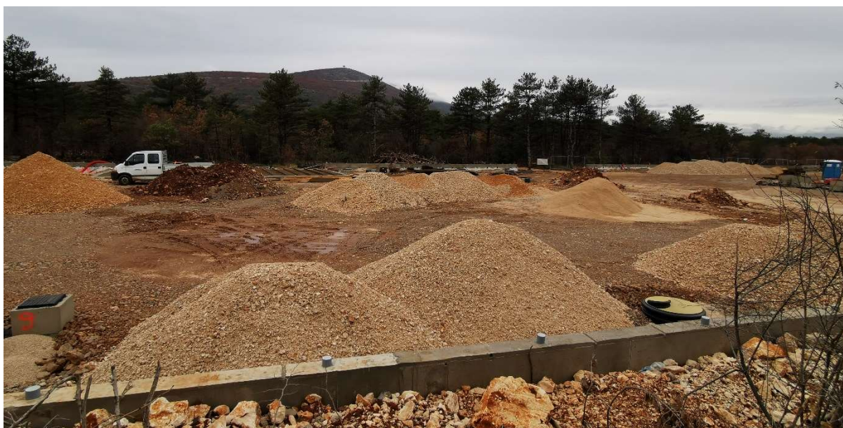
Slika 3: Prikaz radova na izgradnji Pretovarne stanice Sinj (prosinac 2023.)
