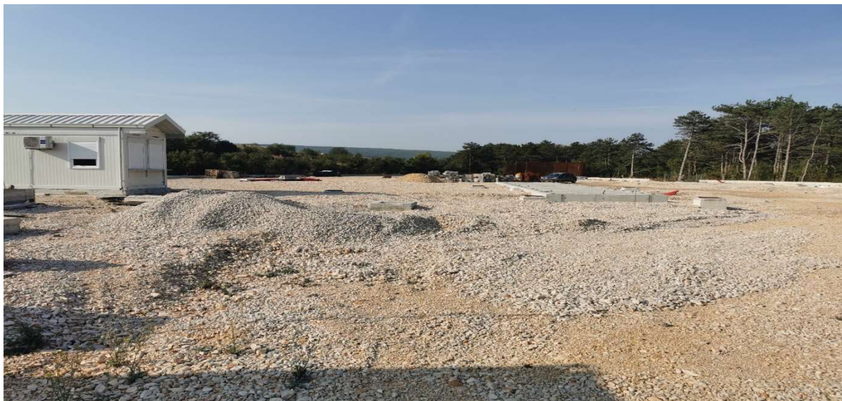
Slika 4: Prikaz radova na lokaciji Pretovarne stanice Sinj (prosinac 2024.)
