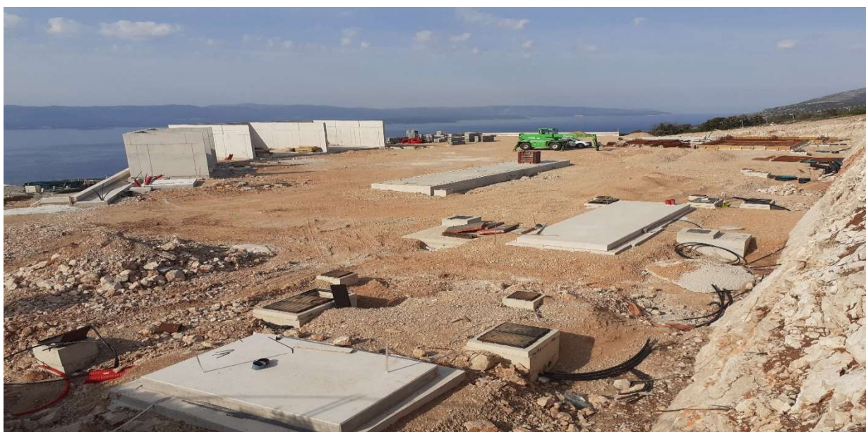
Slika 6: Prikaz radova na lokaciji Pretovarne stanice Brač (prosinac 2024.)
