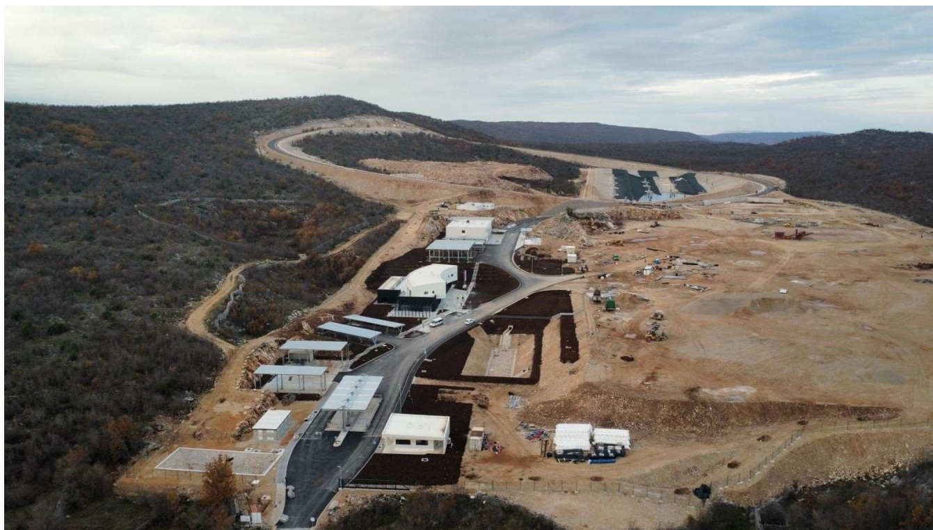
Slika 3: Prikaz radova na lokaciji Centra za gospodarenje otpadom u Kladnjicama u Općini Lečevica (prosinac 2024.)
