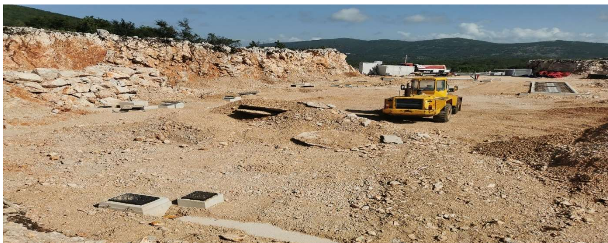
Slika 5: Prikaz radova na lokaciji Pretovarne stanice Zagvozd (prosinac 2024.)
