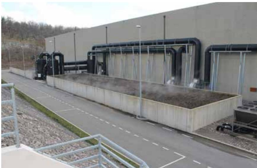
Centri moraju imati funkcionalne biofiltre u kojima se odvija proces čišćenja hlapljivih spojeva iz otpadnih plinova (neugodni mirisi)
