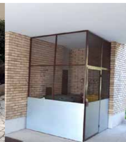
Uređen boks za kontejnere za odlaganje otpada dostupan samo stanarima višestambene zgrade
