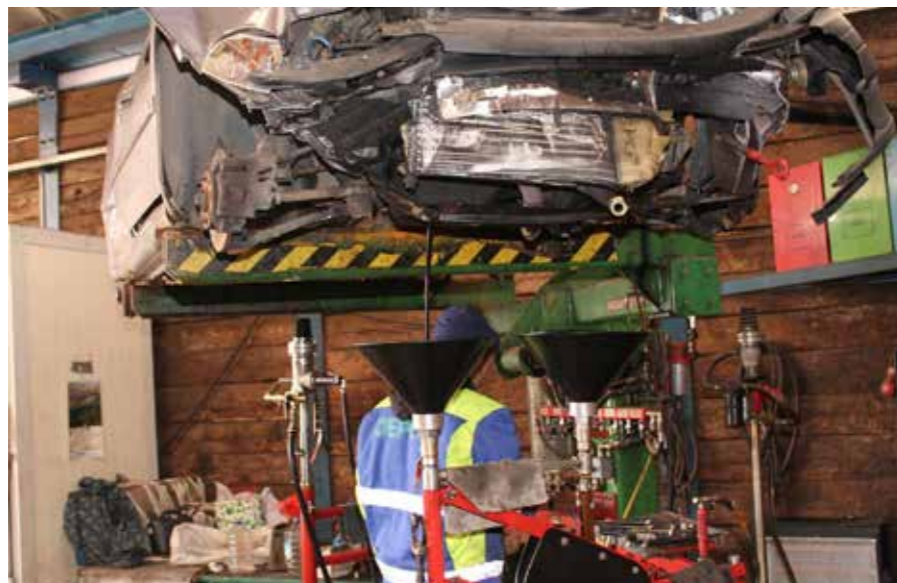
U prvom koraku obrade otpadnog vozila izdvajaju se opasne tekućine (motorno, hidraulično i kočiono ulje, gorivo: benzin i dizel, rashladna tekućina za motor, tzv. antifriz, tekućina za pranje stakla). Tek nakon postupka „isušivanja“ otpadno vozilo može se dalje obrađivati.
